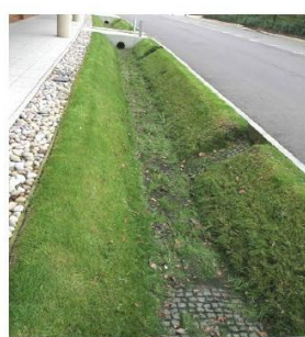
Noue de récolte des eaux de ruissellement des toitures et des voiries alimentant le bassin de rétention paysager
