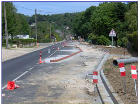
Travaux de Voirie 1 628 000 €
