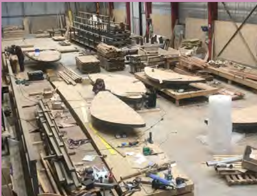
Fabrication des coques en platelage bois.
