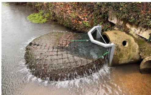
Ce dispositif, capable de retenir jusqu'à 4 tonnes de déchets, permettra de préserver la Veules, un cours d'eau emblématique du territoire, tout en garantissant un meilleur écoulement des eaux pluviales.
