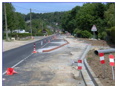
Travaux de Voirie 1 427 000 €
